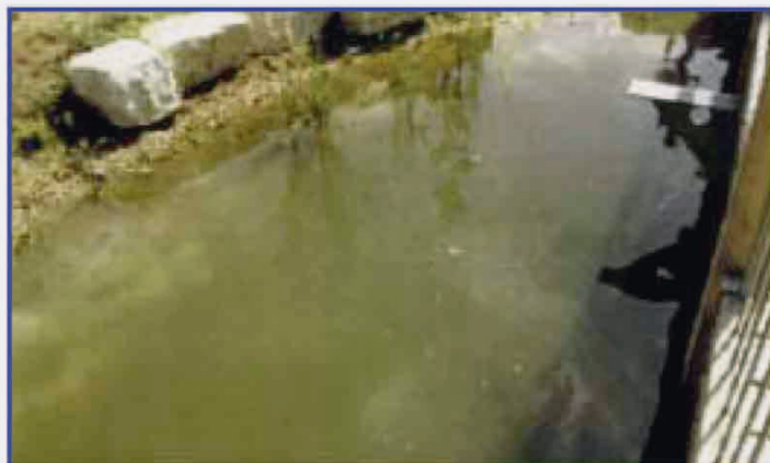
Etat avant le traitement au penac
