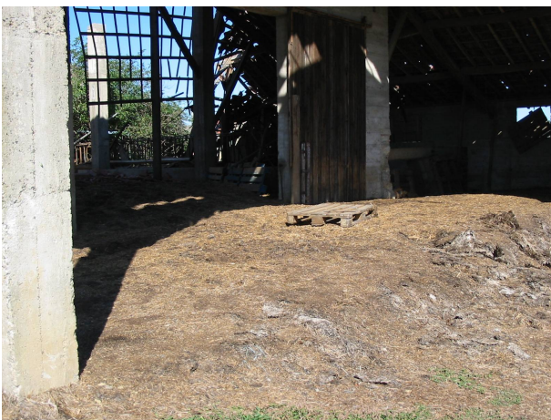
Photos du fumier à l'intérieur et l'extérieur de la bergerie.
