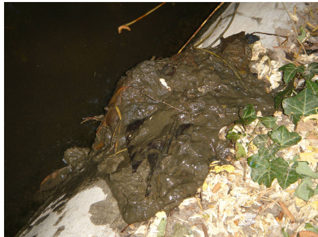
Déchets verts dans la partie traitée
